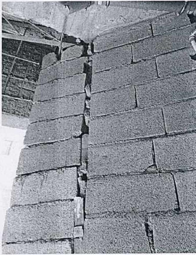
شکل ۶- عدم اتصال صحیح بین دو دیوار غیر سازه‌ای.
