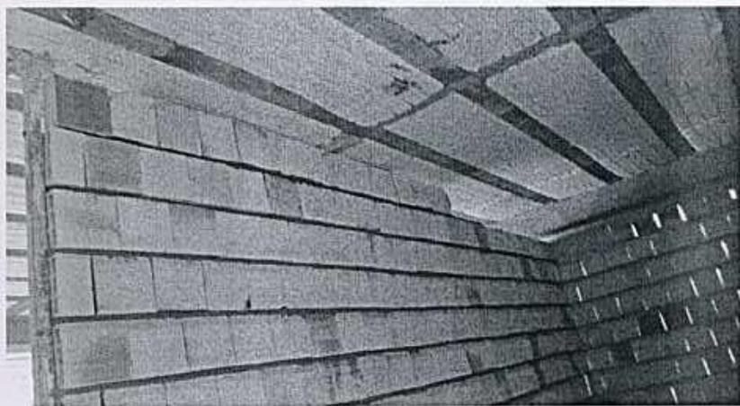
شکل ۷- عدم تراشیدن بلوک پلی استایرون (به جای استفاده دیوار بین واحدهای مستقل تا زیر بدن سقف.)
