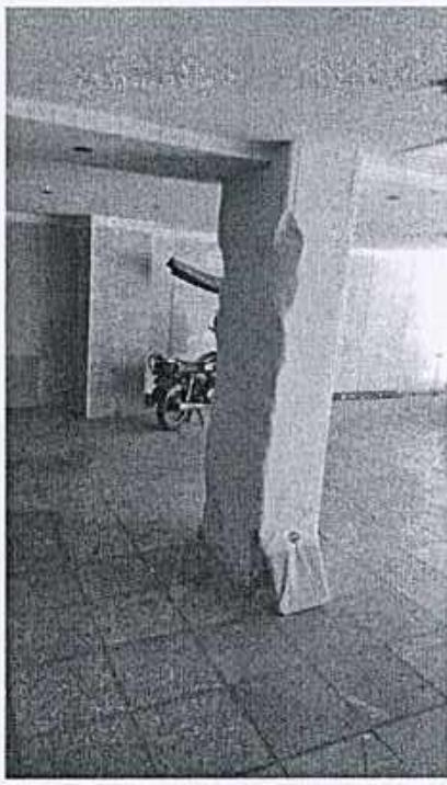
شکل ۲- تخریب ستون برای تامین دهانه پارکینگ، به علت عدم دقت در اجرای ستون ها یا عدم احتساب نازک کاری در حین اجرا.
