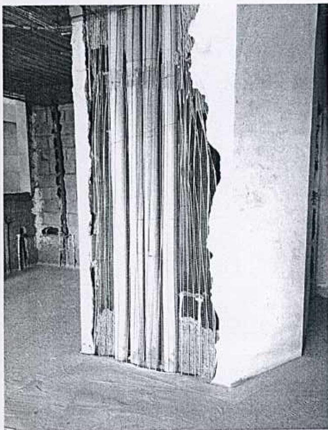
شکل ۱۰- تخریب دیوارها جهت عبور لوله های تاسیساتی
