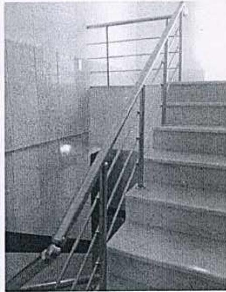
شکل ۱۹- استاندارد نبودن ارتفاع نرده دست‌انداز پله (کمتر از ۹۰ متر است) و فاصله قیدها پس از صورت افقی و بیشتر از ۱۱۰ متر می‌باشد.
