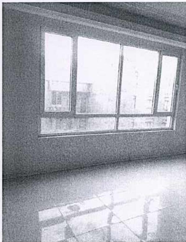
شکل ۹- عدم رعایت ارتفاع پنجره از کف و بزرگی بیش از حد.
